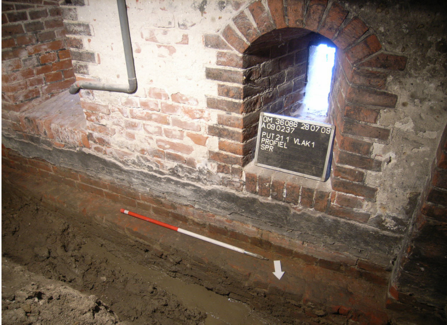
Afb. 6.2 Structuur 1 in ruimte 23. Het is goed te zien dat het muurwerk van het châtelet is gebouwd op de 15e-eeuwse ommuring van de voorburcht.
